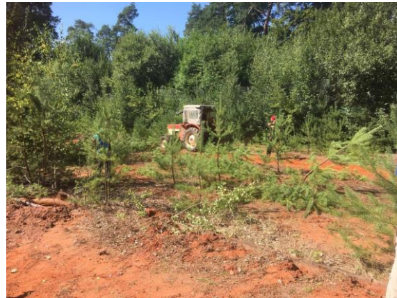
Vorarbeiten zum Bau des Kleinspielfeldes
