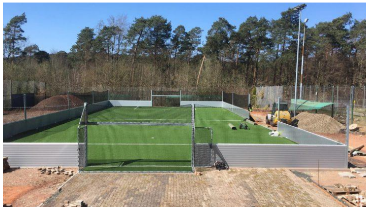
Bau des Kleinspielfeldes auf der Heide
