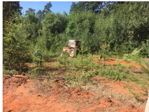
Vorarbeiten zum Bau des Kleinspielfeldes
