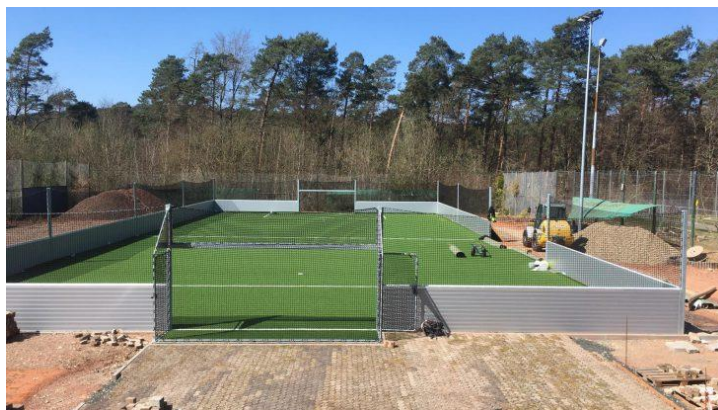
Bau des Kleinspielfeldes auf der Heide
